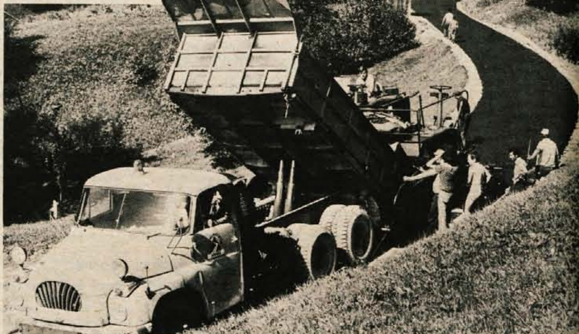
Eden zadnjih velikih »podvigov« Dražgošanov je vsekakor asfaltna prevleka na cesti Češnjica—Rudno—Dražgoše. Čeprav objekt sodi pod okrilje republiške skupnosti za ceste, so vaščani iz svojih žepov prispevali zanj 660.000 din. Sicer pa je v celoti veljal 4 milijone dinarjev. Posnetek, vzeti iz našega arhiva, je nastal lansko jesen. — Foto: F. Perdan
