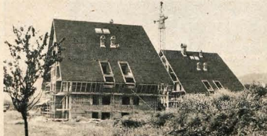
34-stanovanjski blok v gradnji na Jaršah na Bledu — projektanta: arhitekta Milan Jerala in Radovan Jemc
