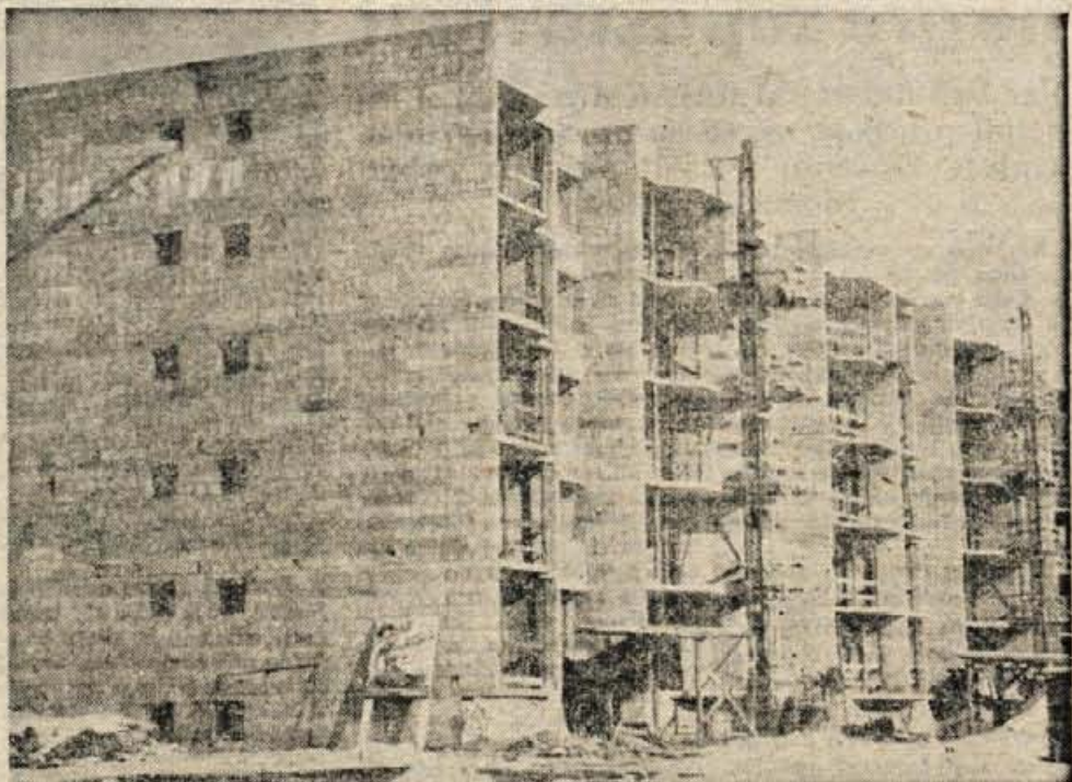
V Radovljicih grade nov blok, tokrat iz ISO-SPAN.
