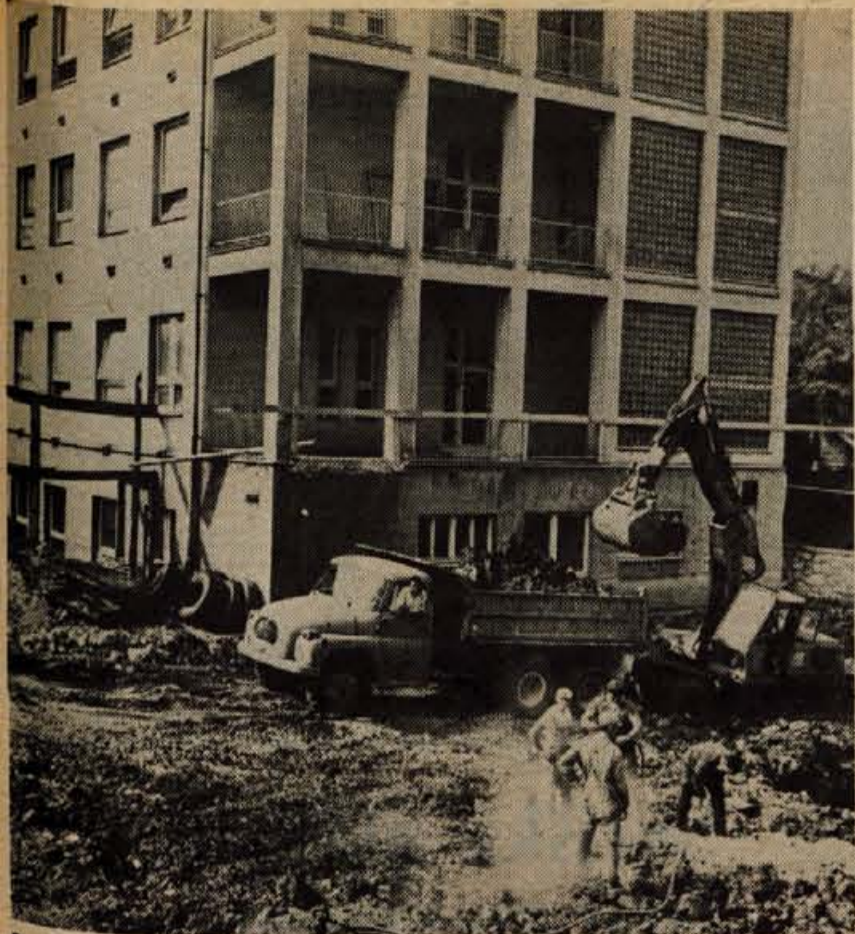
Pred časom so začeli pri kranjskem zdravstvenem domu s pripravljanimi deli za gradnjo prizidka. V štirih etažah bo na 1500 kvadratnih metrih prostora za otroški in šolski dispanzer ter za dispanzer za medicino dela. V kletnih prostorih prizidka bo 16 metrov dolg bazen s toplo vodo in napravami za podvodno masažo, banjami za razgibanje ipd. Bazen bo lahko nadomeščal zdravljenje v toplicah. Računajo, da bodo objekt, katerega proračunska vrednost je 7,5 milijona din, dograjen do leta 1975. Denar je zagotovila komunalna skupnost socialnega zavarovanja Kranj. — Foto: F. Perdan
