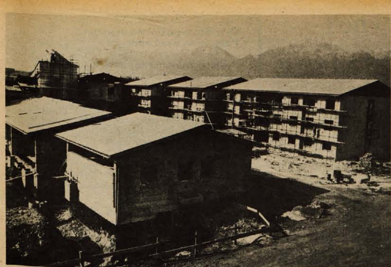
Gradbena dela Doma upokoencev na Planini gredo h koncu: del fasade je že urejen, pa tudi v stanovanjskem delu delavci že polagajo parket po sobah. V Domu bo prostora za 120 upokoencev. — Foto: Perdan
