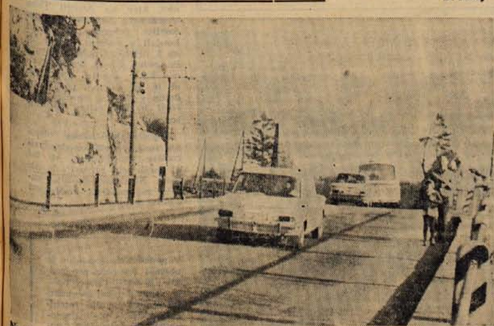
Na Soteski med Potoki in Koroško Belo nameravajo obnoviti cesto, ob njej pa je železnica, za katero prav tako predvidevajo dvotirno progo. Strokovnjaki predlagajo, da bi za železnico zgradili predor, ki pa bi bil dobrodošel že sedaj, saj se na tem mestu neprestano vsipa skalo in gruča na železniško progo. — Foto: B. Blenkuš
