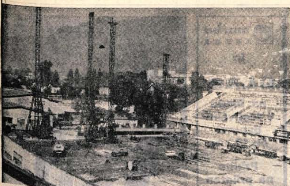
Nad hokejskim igriščem pod Mežakljo postavljajo novo halo. — Foto: B. Blenkuš
