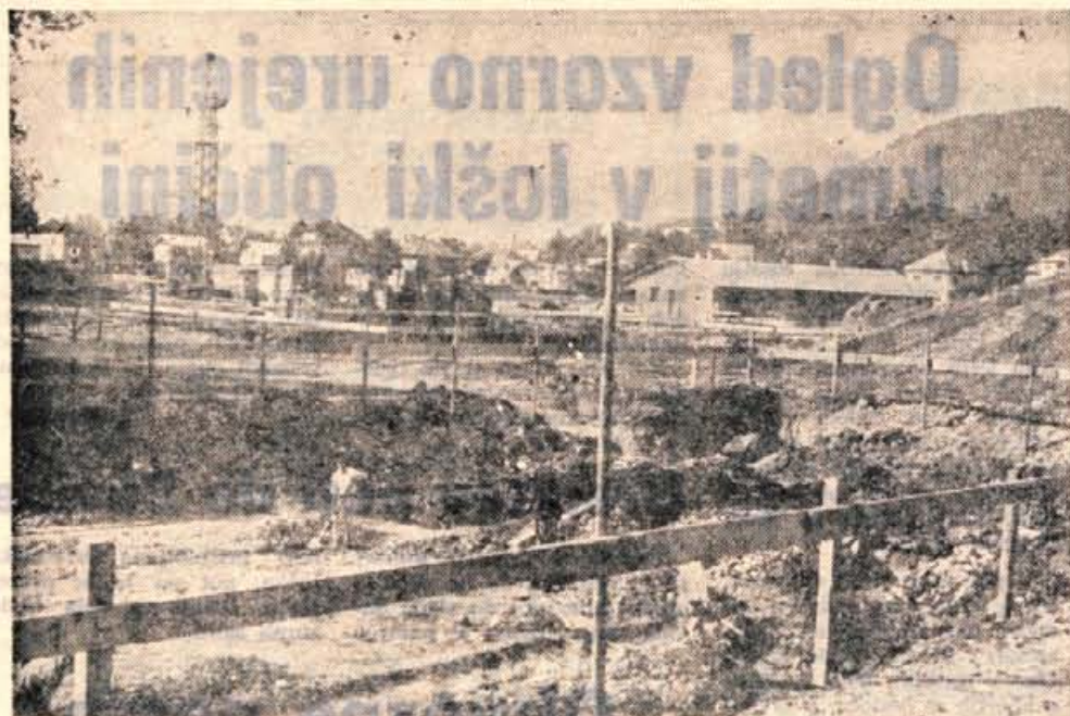
Gradbišče novega stanovanjskega naselja na Planini. — Foto: F. Perdan
