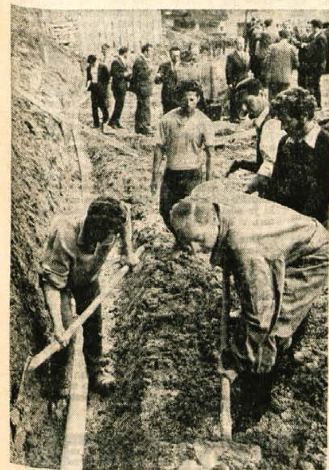
Delavci Cestnega podjetja iz Kranja so pri gradnji ceste skozi Senično praktično pokazali polaganje novih plastičnih cevi.
