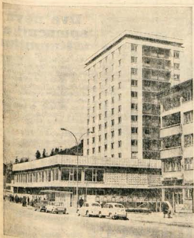
Nasproti jeseniške železniške postaje gradi SGP Sava Jesenice nov poslovno stanovanjski objekt, ki bo odprt predvidoma konec tega meseca. V njem bodo imeli poslovne prostore Murka Lesce, Železnina Radovljica, Specerija Bled in Kmetijsko živilski kombinat Škofja Loka. — Foto: F. Perdan
