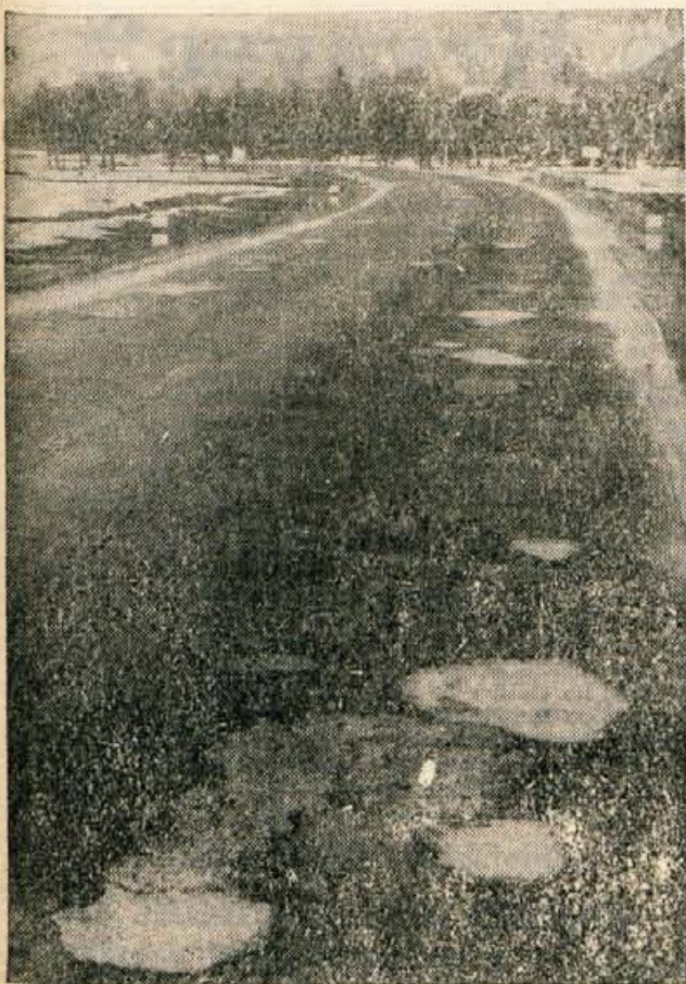
Pravijo, da pomladi vse cveti. Tega nenapisanega pravila so se potem, ko je začel kopneti sneg, »držale« tudi gorenjske ceste, zlasti tam, kjer je bila asfaltna prevleka bolj tanka. Zaradi velikih lukenj so začeli ceste krpiti z novim asfaltom — te dni zalivajo luknje z novo asfaltno prevleko od Most proti Jesenicam pa tudi na drugih cestnih odsekih. (vlg) — Foto: F. Perdan
