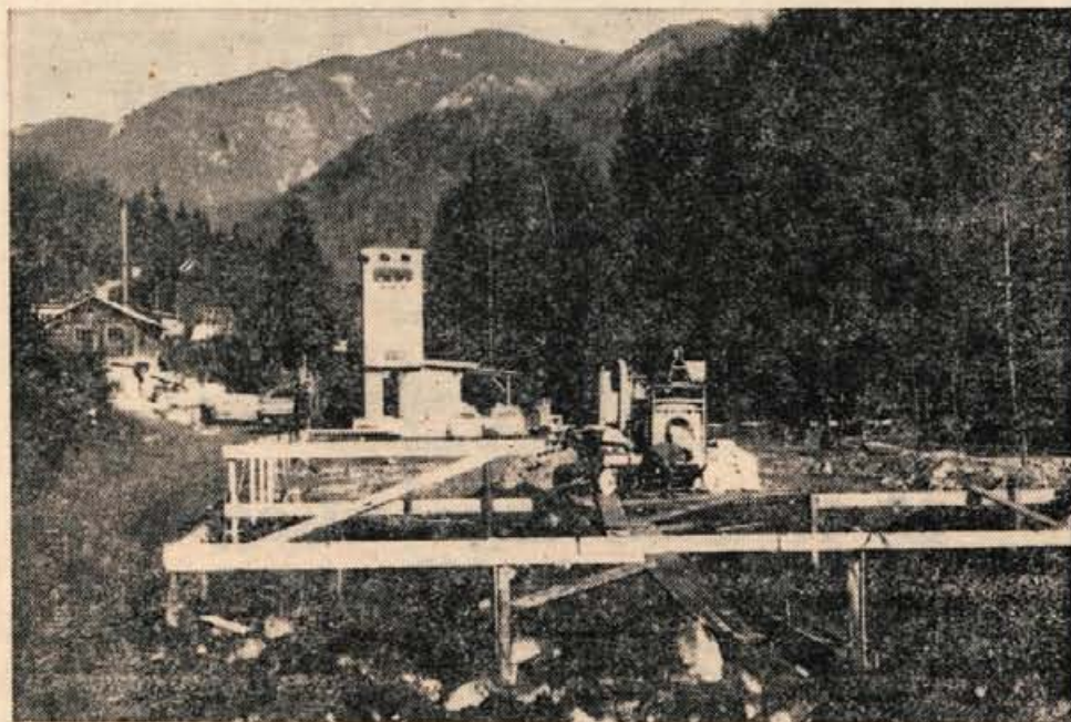
Pogled na gradbišče novega obrata za pridobivanje plošč iz marmornega drobirja v Hotavljah — Foto: F. Perdan
