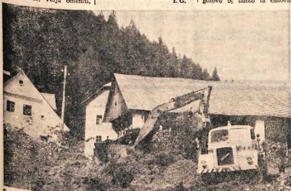
S pobočja pri vasi Podporezno v Selški dolini se je spričo neurja v nedeljo sprožil zemeljski plaz. Velike količine ilovnate zemlje so zatrpale cestišče in onemogočile promet. Na sliki vidimo delavce Cestnega podjetja Kranj, ki z bagrom odstranjujejo oviro.
