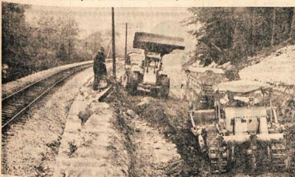
Nekaj težav pa ima podjetje Slovenija ceste na gradbišču v Soteski. Naleteli so na nepredvideno mehak teren. Vendar pa pravijo, da bo cesta 1. oktobra odprta že za ves promet. — Foto: F. Perdan
