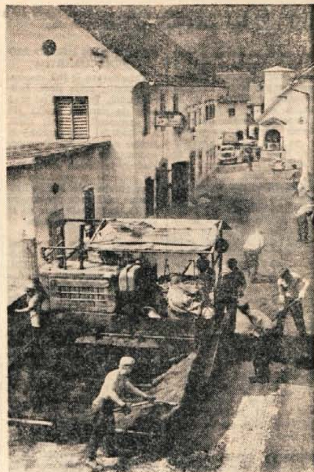
Te dni delavci Cestnega podjetja iz Kranja polagajo še zadnjo plast finega asfalta na cesti v Selško dolino.
