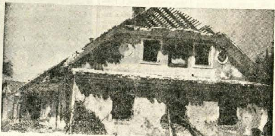
Pred kratkim so delavci komunalnega servisa Kranj podrli Pukljevo hišo v Stražišču, kjer je bila včasih gostilna, sedaj pa že nekaj časa nihče ni stanoval v njej. Hiša je bila za šoferje, ki so vozili po Škofjeloški cesti, velika ovira — Foto Franc Perdan
