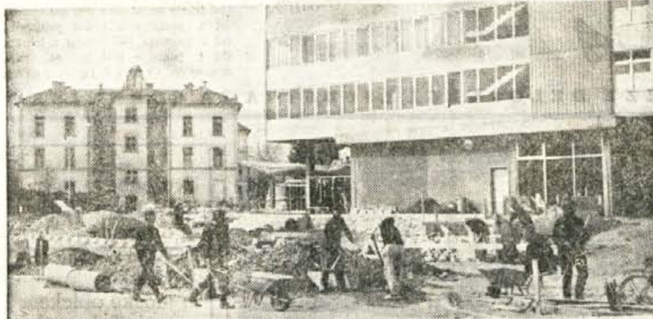
PARKIRNI PROSTOR — Te dni urejajo v Radovljici ob avtobusni postaji ter pred Grajskim dvorom nove parkirne prostore. Na sliki: delavci med delom ob avtobusni postaji
