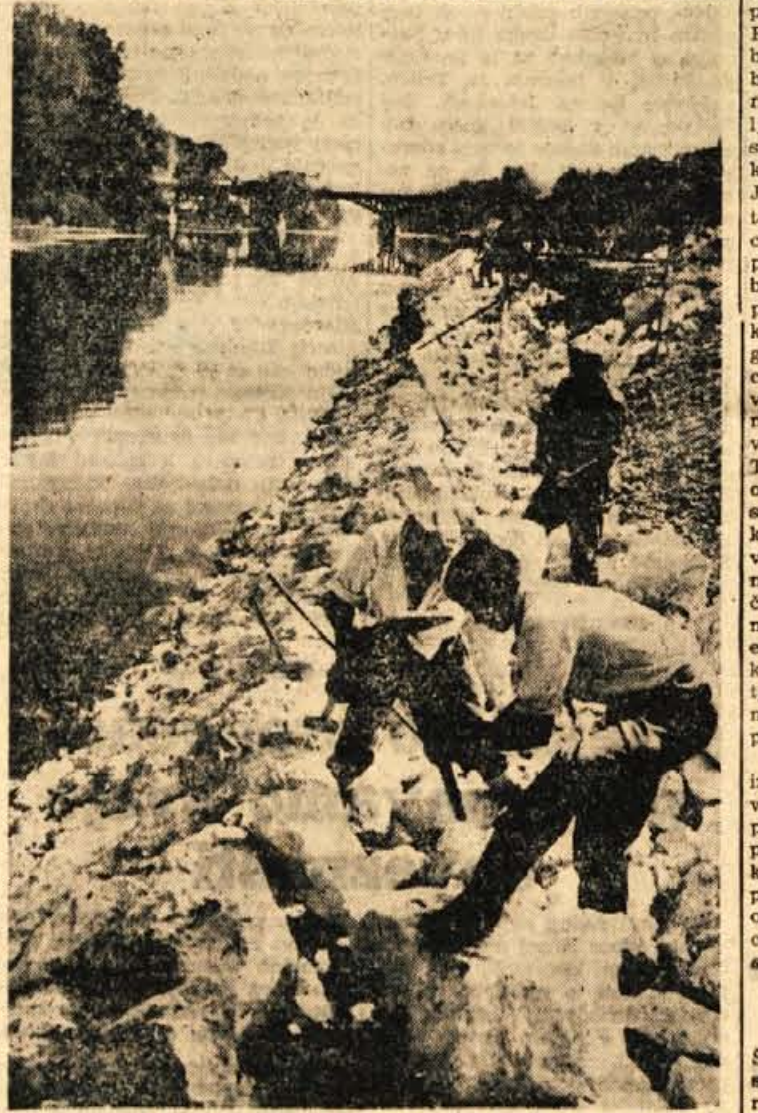
Sušno vreme in nizek vodostaj ugodno vplivata na potek del pri regulaciji rečne korita Save pri Kranju. Strugo bodo obložili s ploščami, s čimer bodo prepričali izpodjedanje bregov...
