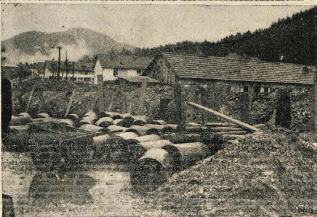
Preskrba z živili je v Stražišču že nekaj let morda najbolj pereč problem. Pred kratkim pa se je to vprašanje končno le premaknilo z mirne točke, kot pravimo. Slika prikazuje začetna dela pri gradnji novega poslopja — potrošniškega servisa
